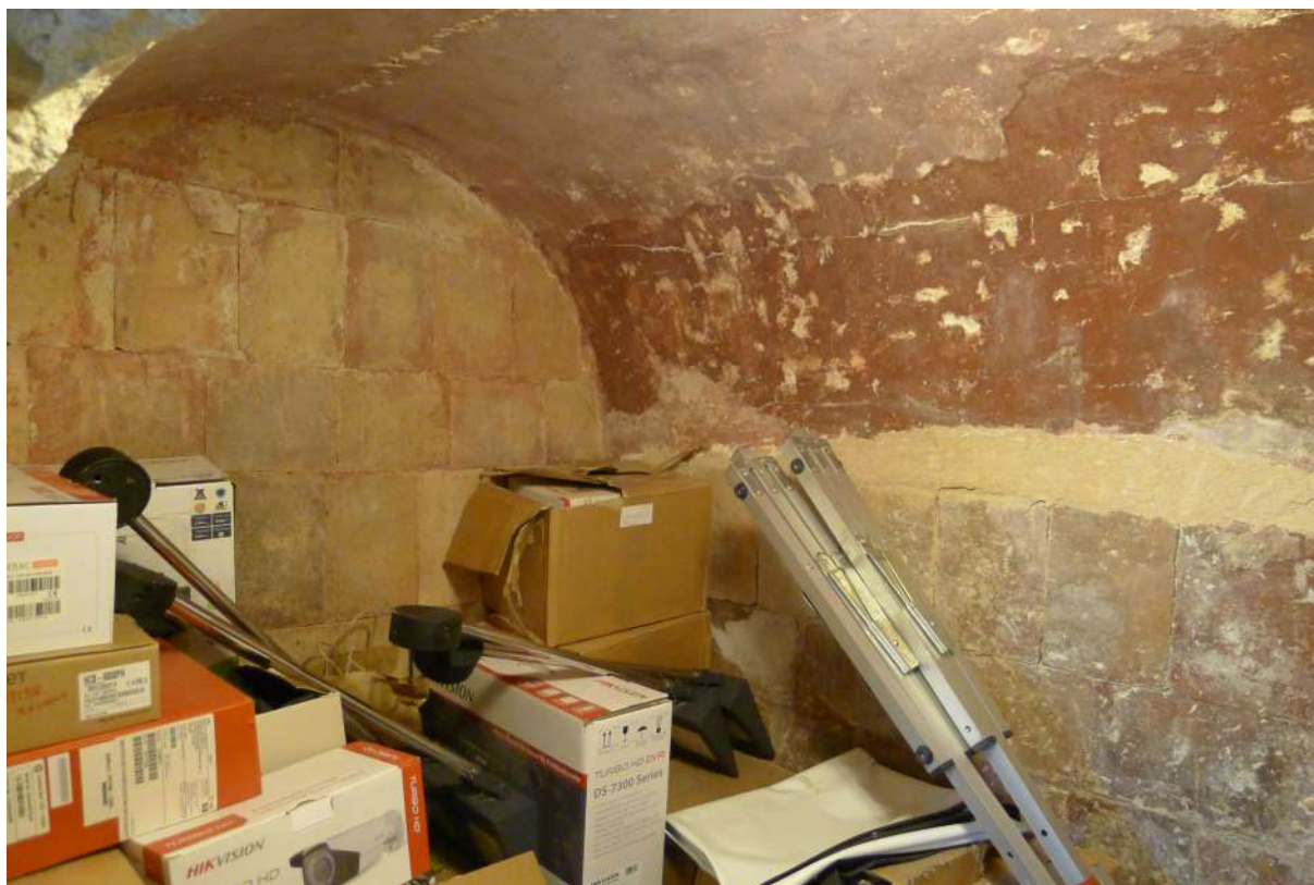
Figura 29. Interior del aljibe (UE1098) y comunicación con el pozo en el lado sur de la Etapa 0.
