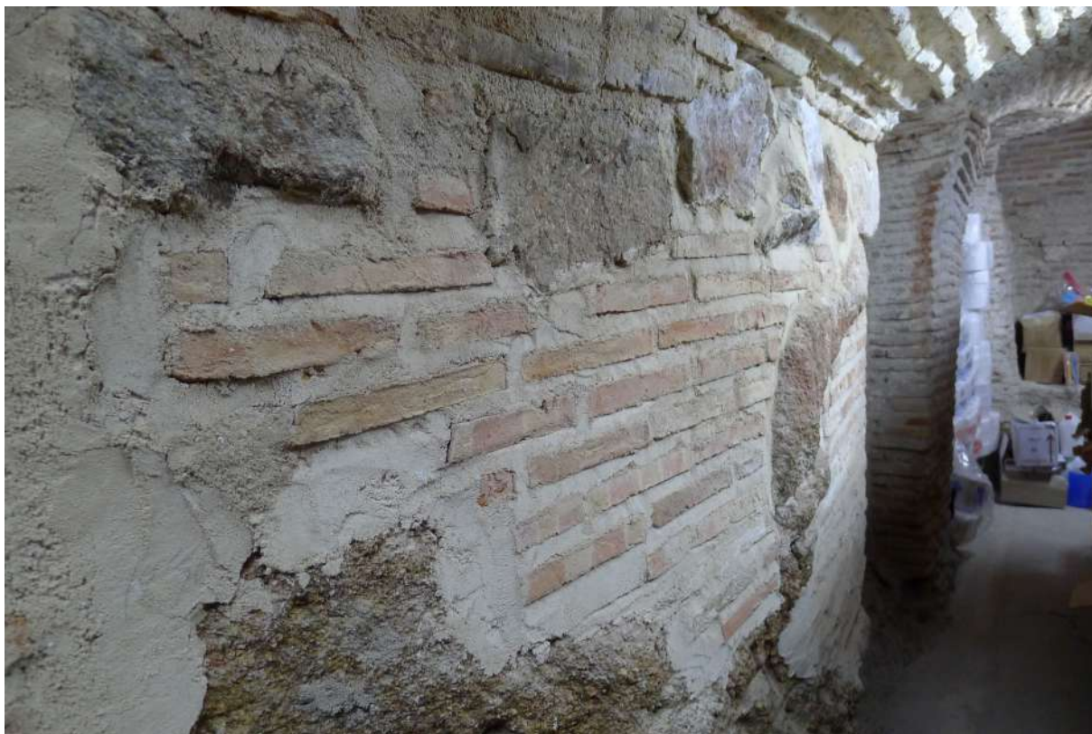
Figura 30. Alzado norte de la cámara subterránea con el pilar central (UE1100).
