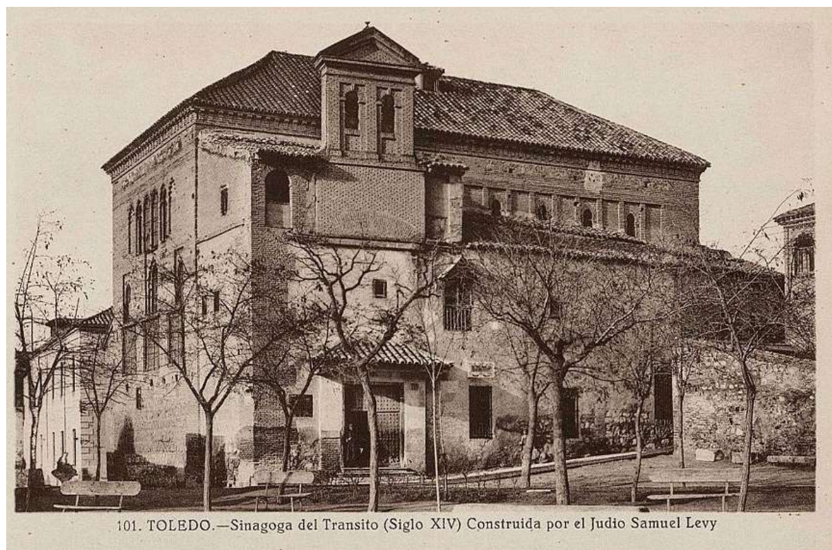
Figura 53. Vista desde el sur, ca. 1930 (AMT), con el ventanuco inferior abierto en la fachada oeste de la sala principal (Etapa II, UE1031) y la pareja de ventanas en la fachada correspondiente de la nave sur.
