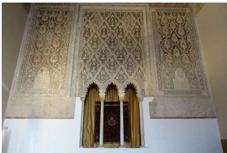
Figura 40. Alzado interior de la sala principal (UE1077) de la Etapa I, huecos del retablo instalado en la Etapa II (UE1078) y restaurados en la Etapa IVa (UE1079).
