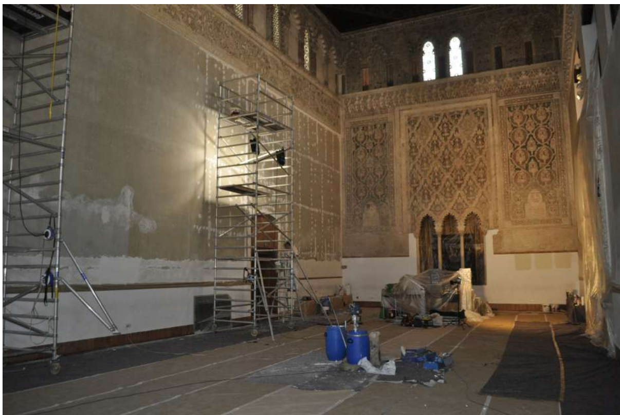
Figura 3. Estado de los muros tras eliminar las tapicerías con las marcas dejadas por los clavos. Fotografía Museo Sefardí.
