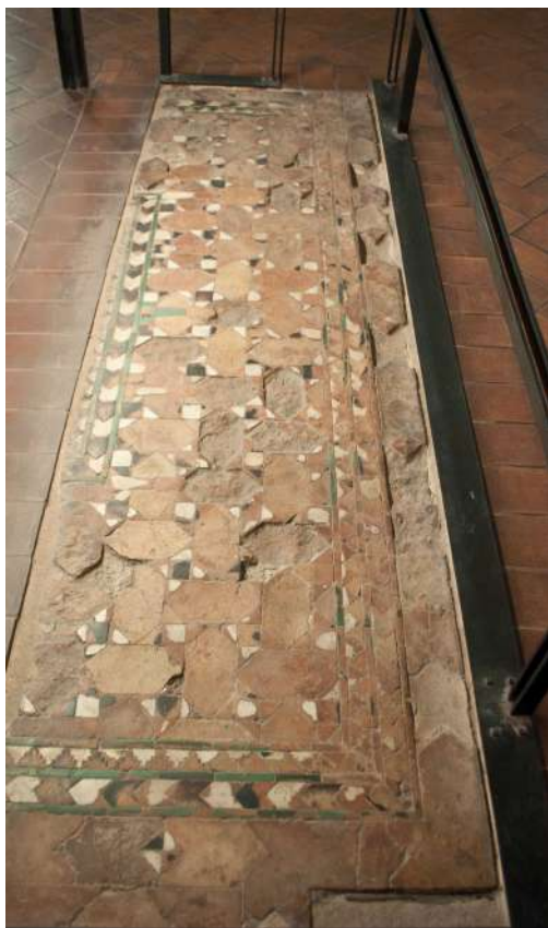
Figura 6. Detalle del pavimento original. Fotografía Museo Sefardí.
