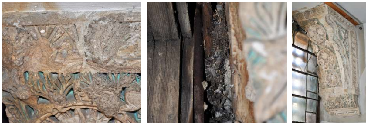
Figura 14. Detalle de la zona superior, zona interna con la viga de obra detrás y vista general. Fotografía Museo Sefardí.
