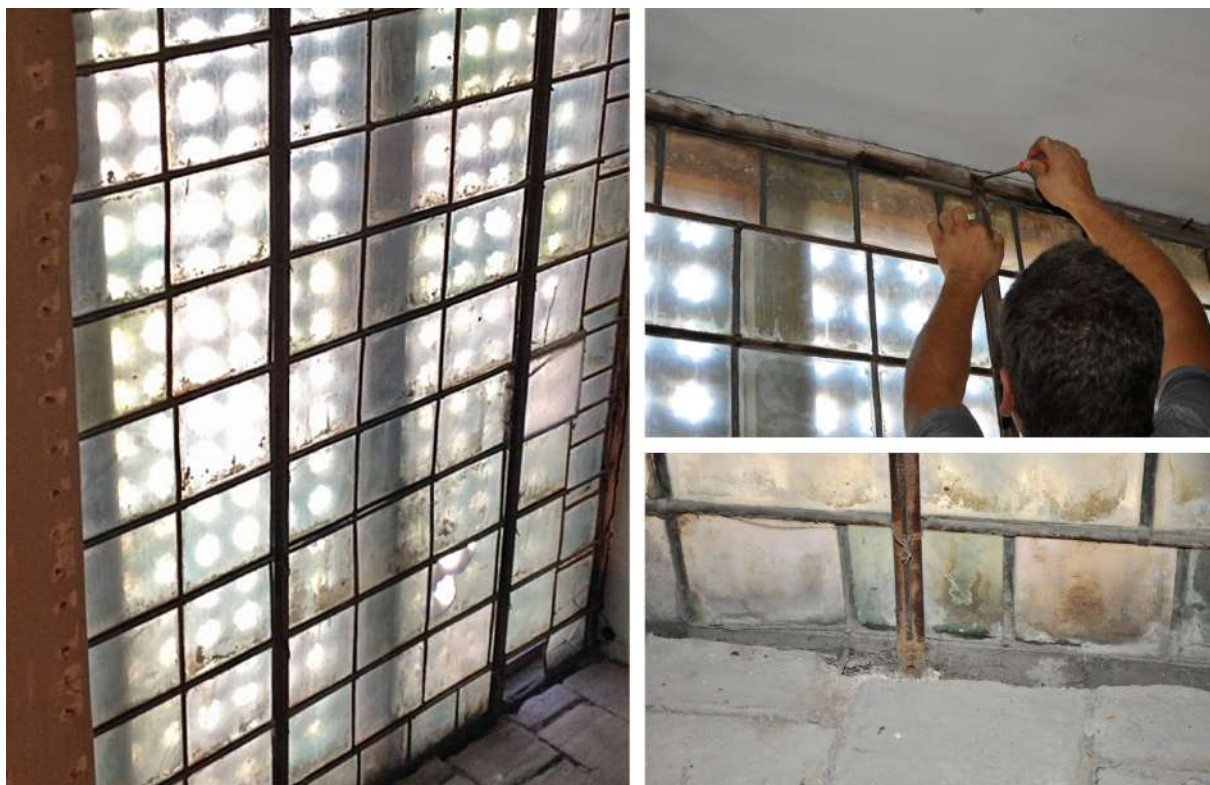
Figura 6. Estado de los emplomados (izquierda), detalle del marco de madera y los refuerzos de hierro (abajo derecha) y desatornillado y eliminación de los emplomados (arriba derecha). Fotografía Museo Sefardí.
