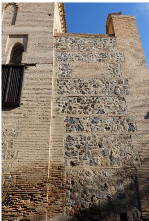
Figura 57. Fachada occidental de la nave sur con vanos sellados (UE1038) y cajones de mampostería alterados en sus extremos septentrionales en la Etapa IVc.
