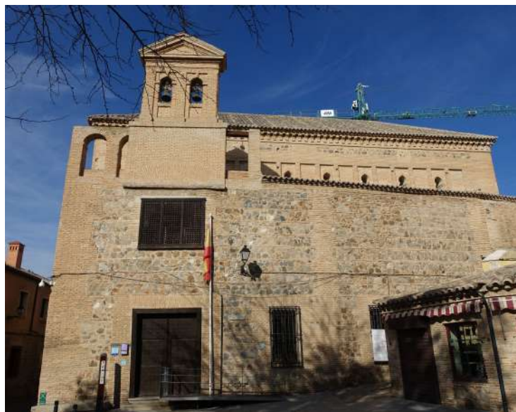
Figura 22. Fachada sur, con posible listel (UE1047) original de la Etapa I, con la parte inferior reconstruida (UE1045) en la Etapa IVa y ventana geminada (UE1006) abierta en la Etapa IVb.
