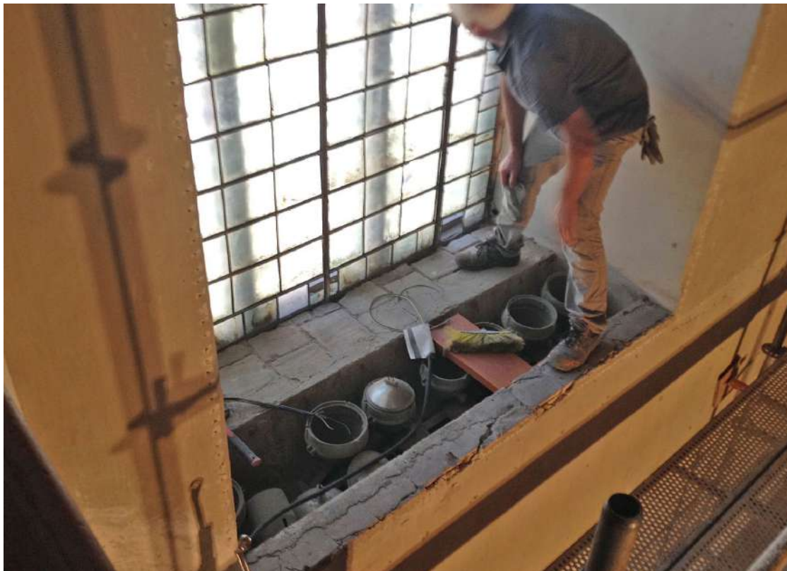
Figura 5. Base de los vanos una vez eliminada la madera. Fotografía Museo Sefardí.
