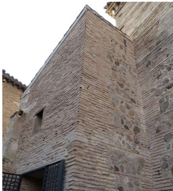
Figura 33 (izquierda). Huella vertical del muro desmontado (UE1094) en la esquina norte de la sala principal y reparación del mismo (UE1003) en la Etapa II.
