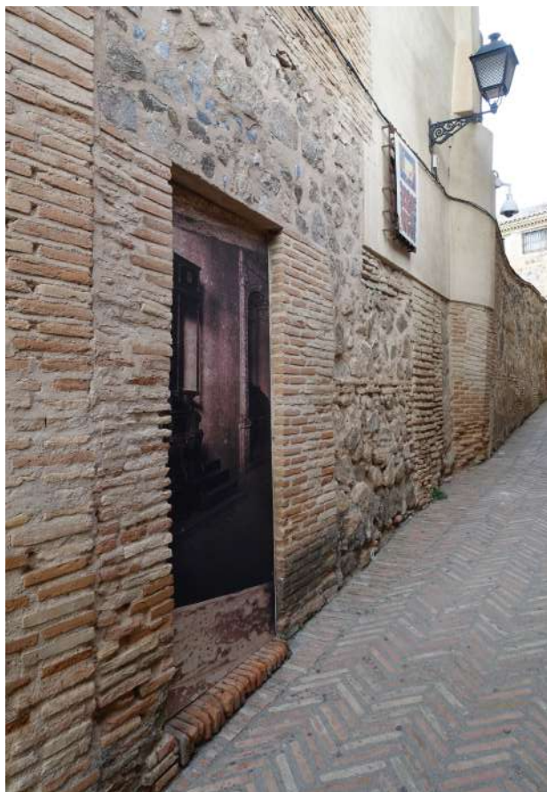
Figura 42. Vano sur de acceso al vestíbulo sureste con restos en sus jambas de puerta originaria (UE1058) y fábrica de mampostería hacia el este (UE1061) de la Etapa I.
