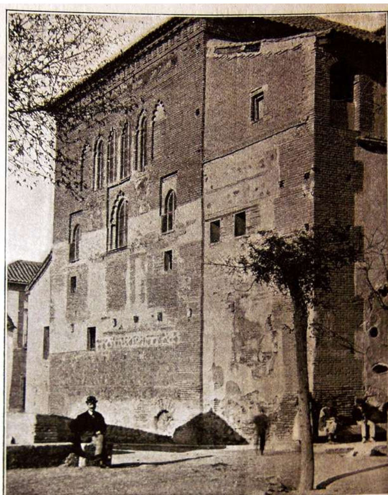
EL TRÁNSITO.— Fachada occidental EL TRÁNSITO.— Façade occidentale
