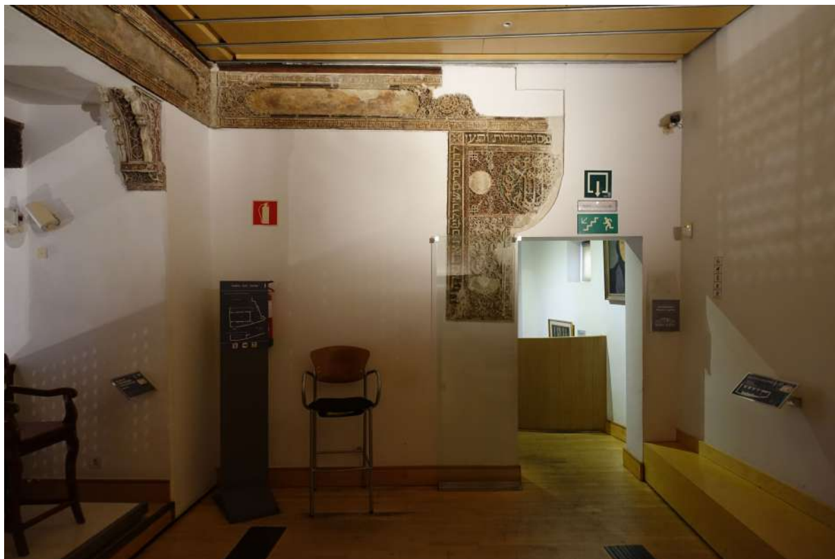
Figura 39. Muro de separación entre nave sur y actual vestíbulo sureste (UE1074) y marco de yeserías del vano y frisos (UE1093) de la Etapa I.
