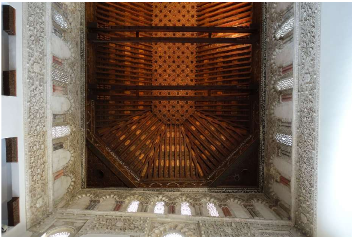
Figura 41. Detalle del apoyo del artesonado (UE0189) de la sala principal y de la corrección en planta de la última, Etapa I.
