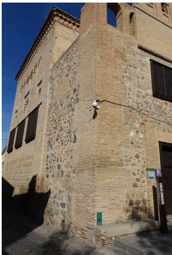
Figura 48. Reforma de la esquina suroeste y alzado del primer campanario (UE1037) en la Etapa II.
