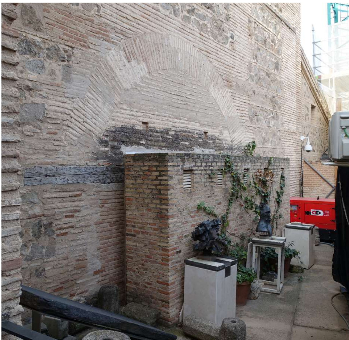
Figura 31. Fachada oriental (UE1002) con arco de ladrillo en el centro y travesaño de madera (UE1004) de la Etapa I; infraestructura del suelo radiante (UE1027) y sellado de huecos y repaso de la fábrica en la Etapa IVc.
