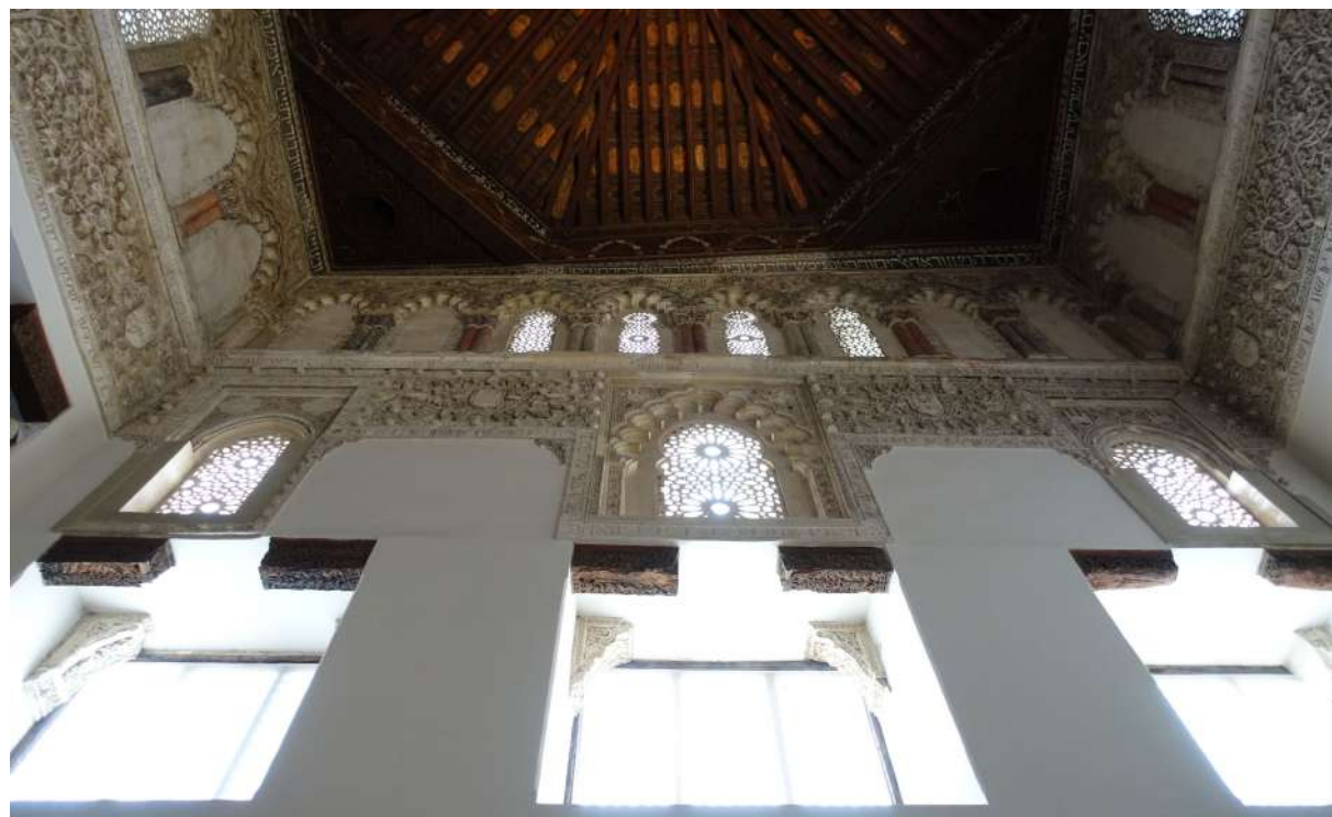
Figura 45. Interior del muro occidental con ventanas del cuerpo central restauradas una vez desmontado el coro (UE1087) en la Etapa II.
