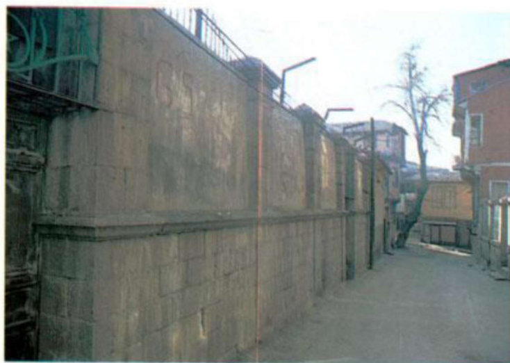
Fig. 21: Tapia exterior de la sinagoga. İlter 1996.
