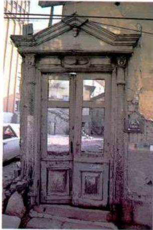
Res. 13 – Ravza-i Terakki (okul) – Ahşap kapı. The School "Ravza-i Terakki" - its wooden gate.
