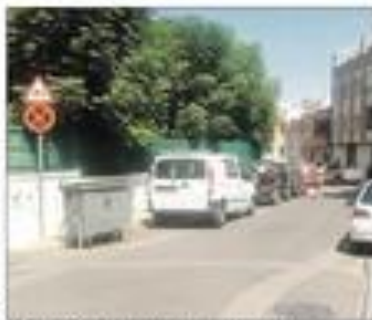
SEGURIDAD. Trabajos municipales en los alrededores de los colegios públicos de Jaén.
